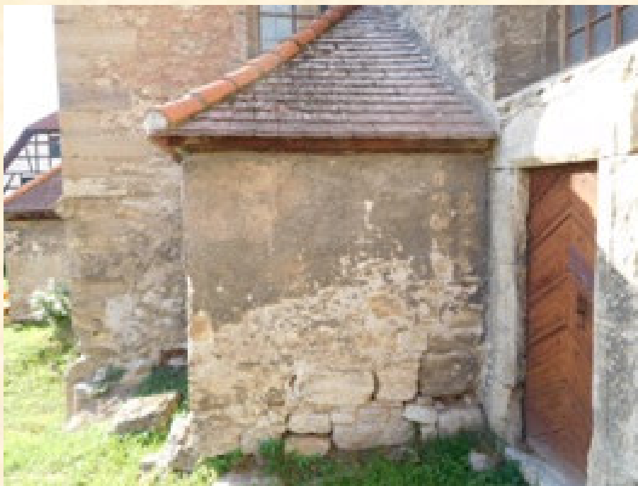
War dies die Klausen an der Südwand des Turmes?
